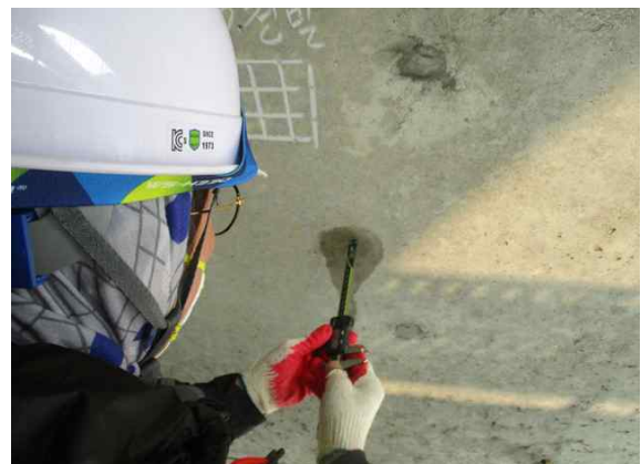
b. 탄산화 깊이 측정
